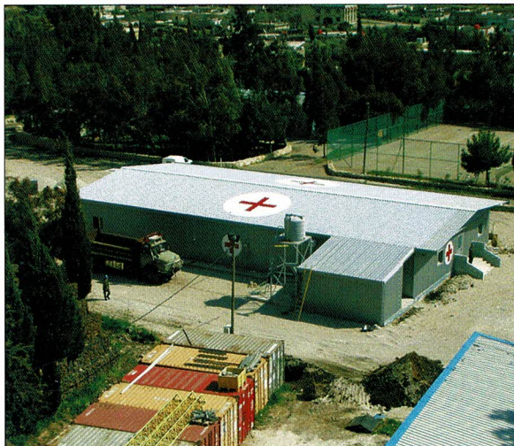
Das neue Medical Center im Camp Faouar
